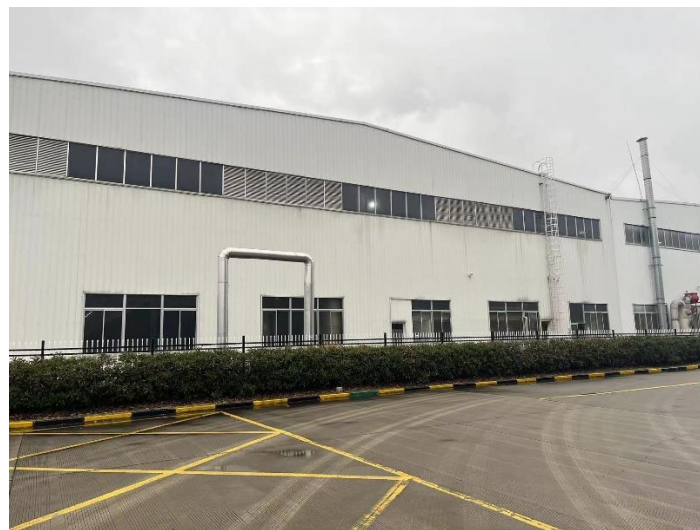
项目西侧：江苏嘉美森环保包装科技有限公司厂房
